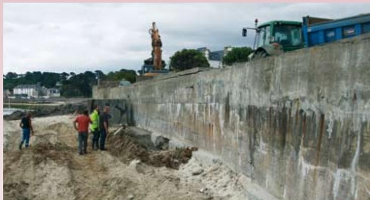
La mer passait en dessous et affouillait la chaussée. L'entreprise SARC a été retenue pour ce chantier, nécessitant de très gros moyens. Une centaine de mètre cube de béton et 150 m3 de matériaux d'appoint sont en effet nécessaires.
