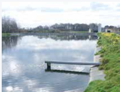
Bassin de décantation
