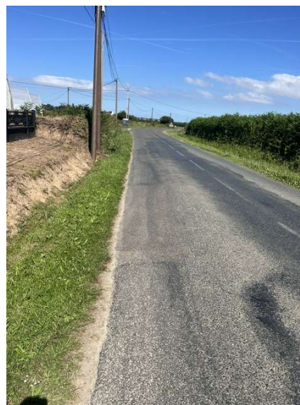
Extrémité du projet côté Plougrescant
