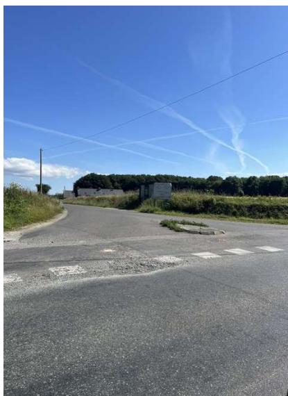
Ilôt central desserte agricole et équipement électrique
